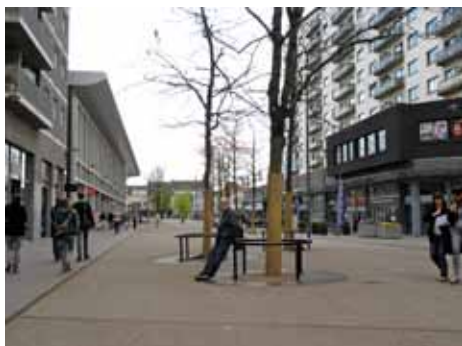
Gietbeton en stalen opsluitbanden in Genk
