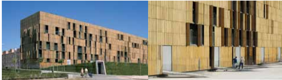
2. Calle de la Trompetas / Foreign Office Arquitectos, 2007
