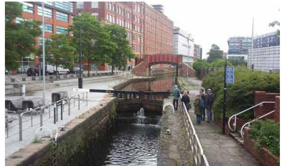
nieuwbouw langs het kanaal
